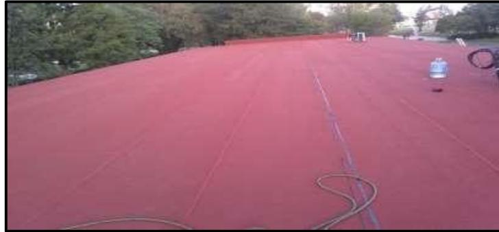
Ilustración 73. Impermeabilización de edificio J.
